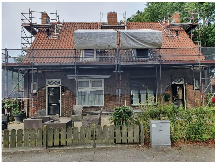
Afbeelding 1.4: Renovatie van 170 woningen in de wijk Hoevenbraak in Schijndel.
