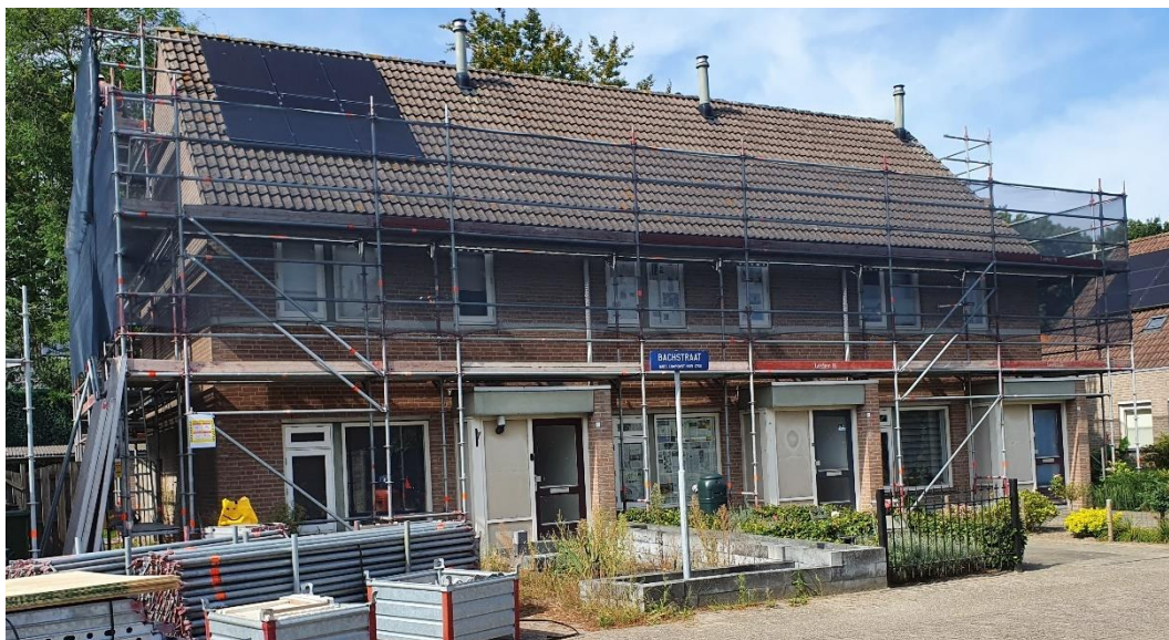
Afbeelding 1.2: Woningen die momenteel door Woonmeij worden verduurzaamd aan de Bachstraat in Sint-Oedenrode.
